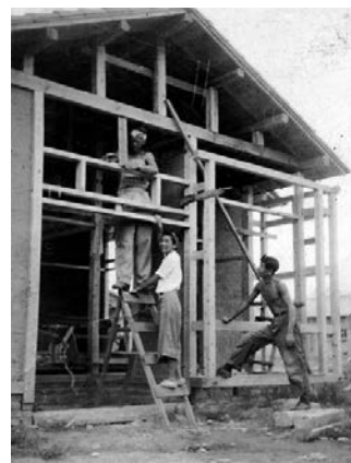
皆実町での住宅建設 1949年(昭和24年)8～9月
