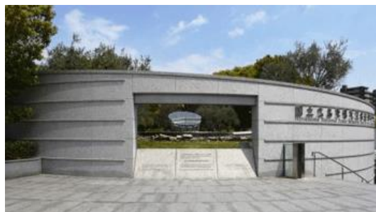
建物の外観（地上部）
