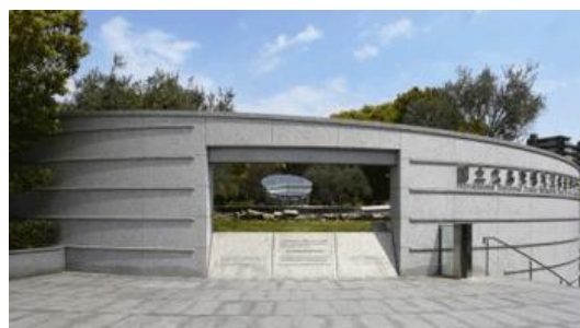
建物の外観（地上部）
