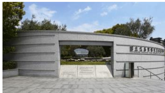
建物の外観（地上部）
