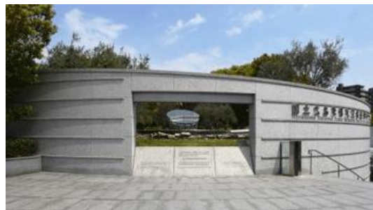
建物の外観（地上部）
