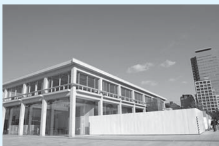
平成28年(2016年)春のリニューアルオープンに向けて、東館を閉館し改修工事を行っています。
