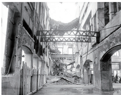
広島駅構内から南東を望む。右手が主待合室で左手側がホーム。この区画は屋根及び2階が崩落している。(1945年11月18日 米軍撮影/平和記念資料館所蔵)
