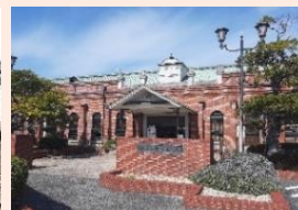
広島市郷土資料館 （旧宇品陸軍糧秣支廠（缶詰工場））
